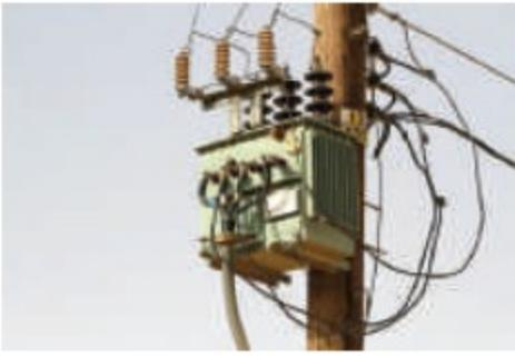
■ الشكل 17-2 تستخدم المحولات الخافضة للتقليل من الجهود الكهربائية الكبيرة في خطوط نقل القدرة إلى مستويات تناسب المستهلكين في أماكن الاستخدام.
