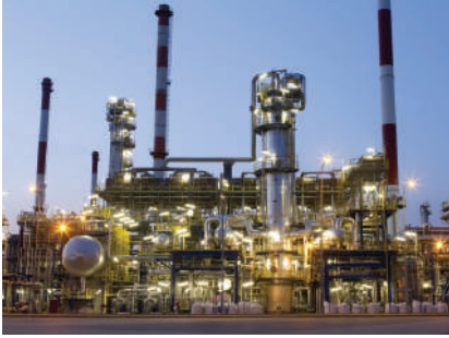
محطة توليد الكهرباء في الجبيل
