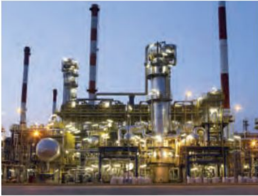
محطة توليد الكهرباء في الجبيل
